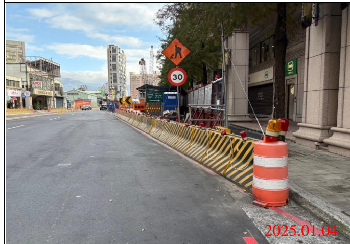
巡查日期地點：114.01.04/ Y22車站 照片說明：牌面設置狀況
