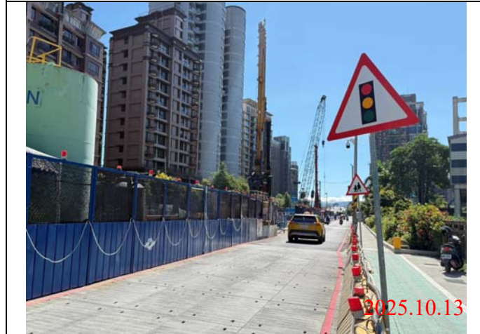
巡查日期地點：2025.10.13 / Y23車站 照片說明：牌面設置狀況
