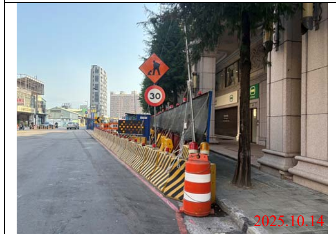
巡查日期地點：2025.10.14 / Y22車站 照片說明：牌面設置狀況
