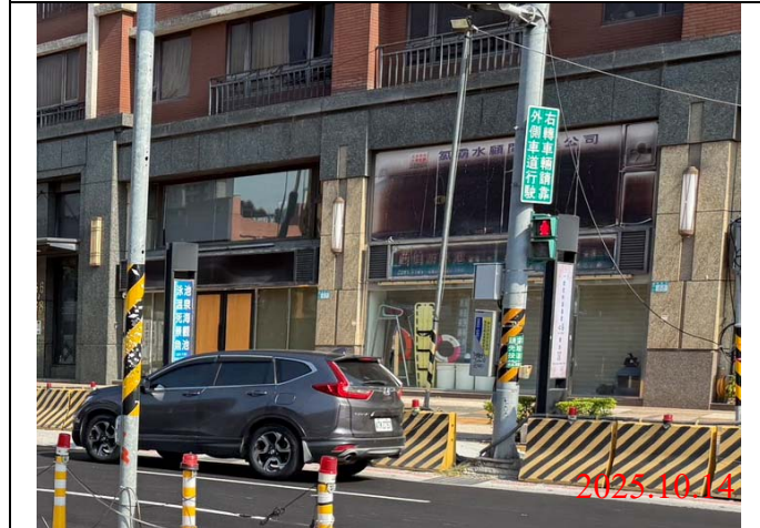
巡查日期地點：2025.10.14 / Y23車站 照片說明：牌面設置狀況
