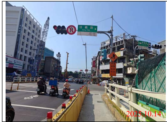
巡查日期地點：2025.10.14 / Y21車站 照片說明：牌面設置狀況
