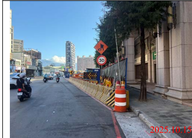
巡查日期地點：114.10.15 / Y22車站 照片說明：牌面設置狀況
