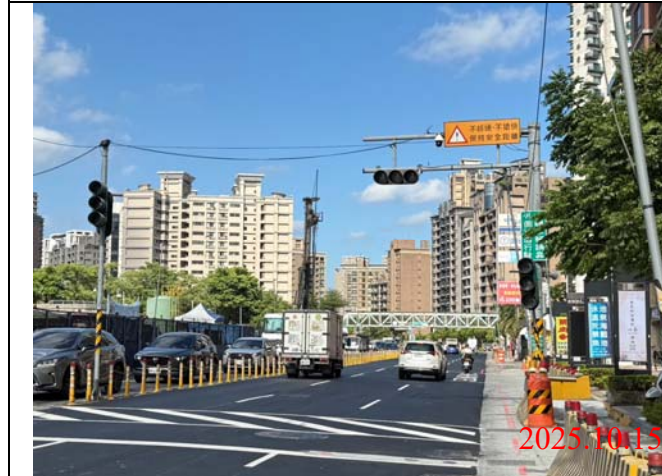
巡查日期地點：114.10.15 / Y23車站 照片說明：牌面設置狀況
