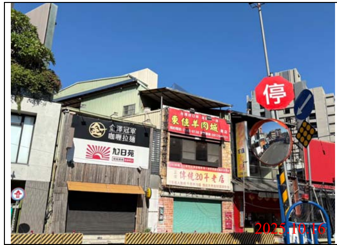
巡查日期地點：114.10.16 / Y21車站 照片說明：牌面設置狀況
