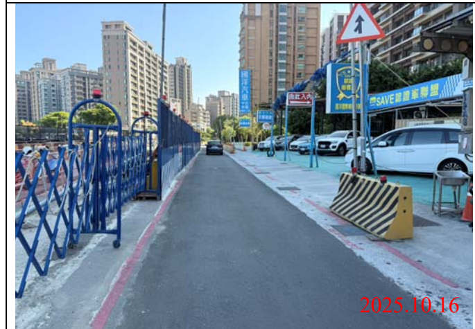
巡查日期地點：114.10.16 / Y23車站 照片說明：牌面設置狀況
