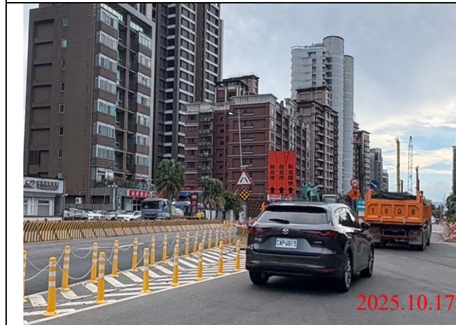
巡查日期地點：114.10.17 / Y23車站 照片說明：牌面設置狀況
