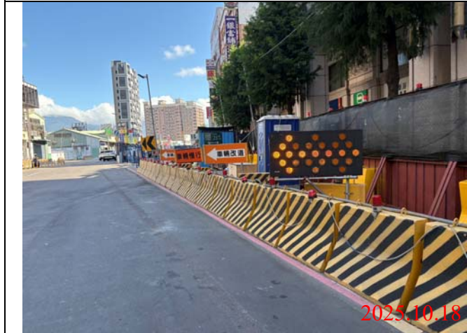
巡查日期地點：114.10.18 / Y22車站 照片說明：牌面設置狀況
