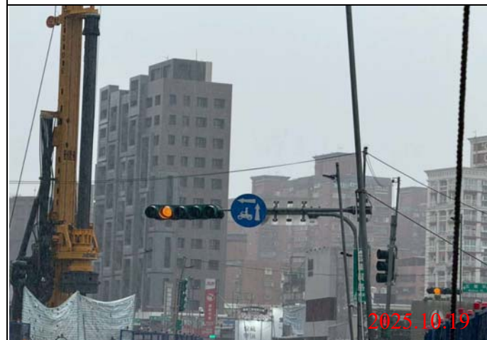
巡查日期地點：114.10.19/ Y22車站 照片說明：牌面設置狀況
