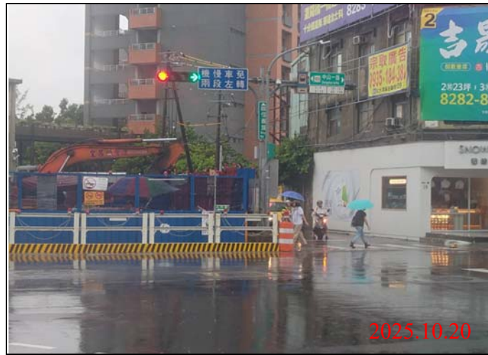
巡查日期地點：114.10.20 / Y21車站 照片說明：牌面設置狀況
