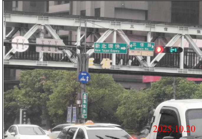
巡查日期地點：114.10.20 / Y23車站 照片說明：牌面設置狀況
