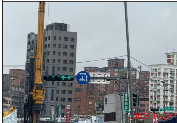
巡查日期地點：114.10.20 / Y22車站 照片說明：牌面設置狀況
