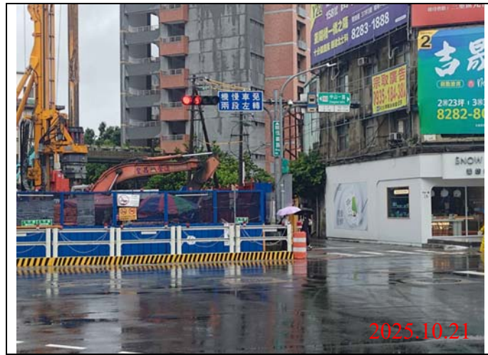
巡查日期地點：114.10.21 / Y21車站 照片說明：牌面設置狀況
