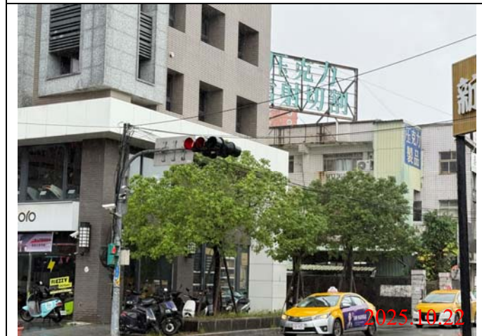
巡查日期地點：114.10.22 / Y22車站 照片說明：牌面設置狀況
