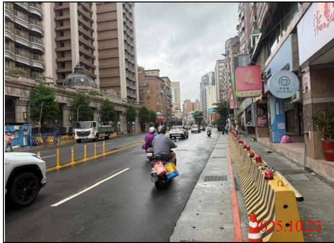
巡查日期地點：114.10.23 / Y22車站 照片說明：路面狀況
