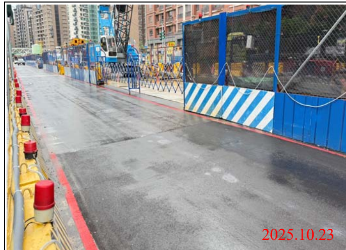
巡查日期地點：114.10.23 / Y23車站 照片說明：路面狀況
