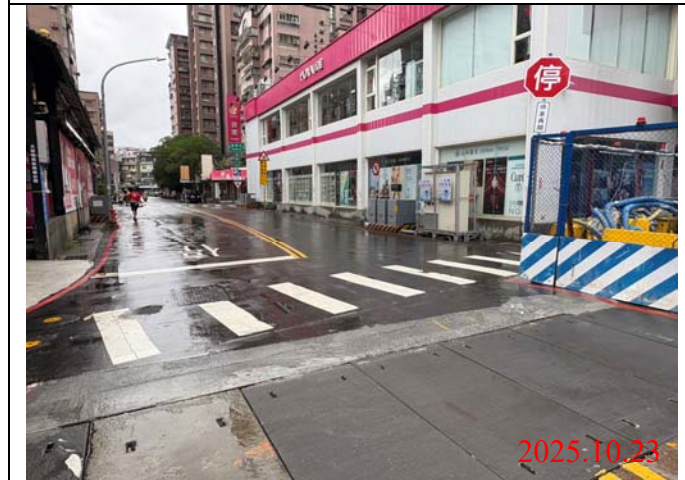
巡查日期地點：114.10.23 / Y21車站 照片說明：路面狀況
