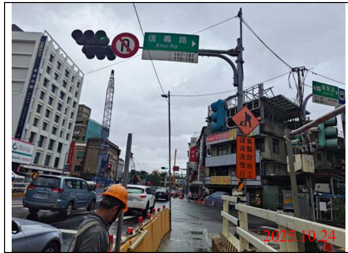
巡查日期地點：114.10.24 / Y21車站 照片說明：牌面設置狀況
