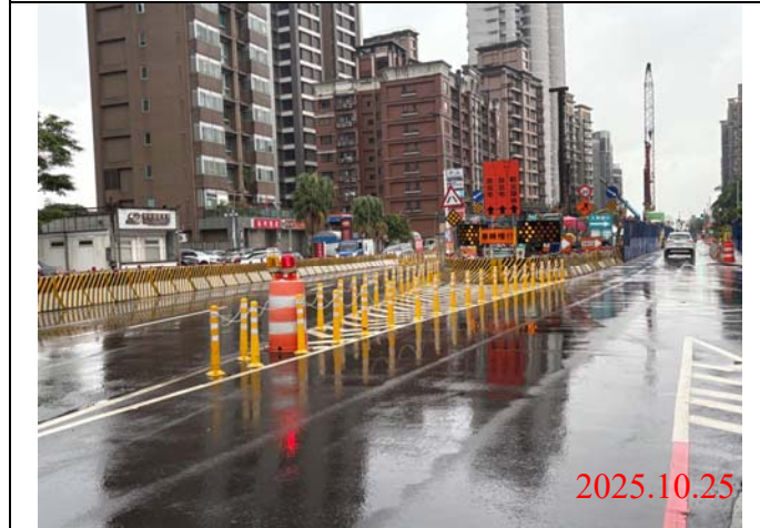
巡查日期地點：114.10.25 / Y23車站 照片說明：牌面設置狀況
