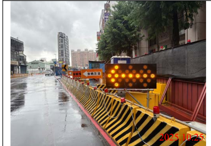
巡查日期地點：114.10.25 / Y22車站 照片說明：牌面設置狀況
