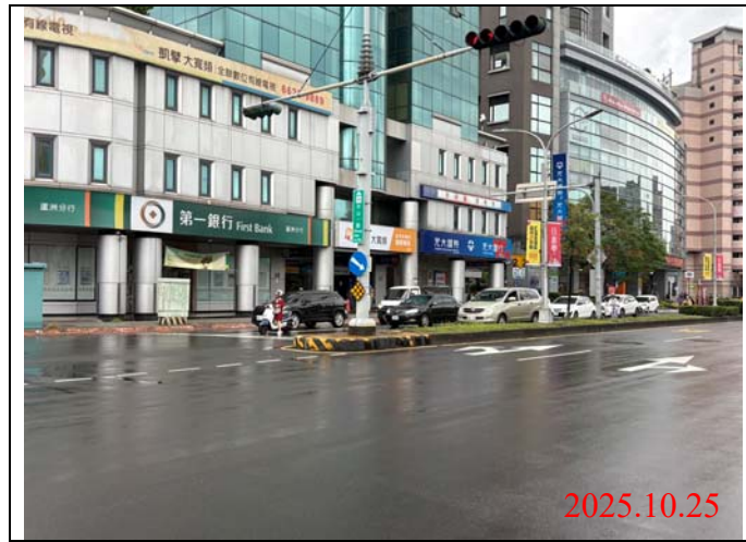
巡查日期地點：114.10.25 / Y21車站 照片說明：牌面設置狀況
