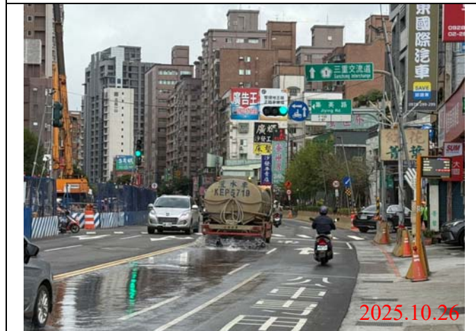
巡查日期地點：114.10.26 / Y22車站 照片說明：牌面設置狀況
