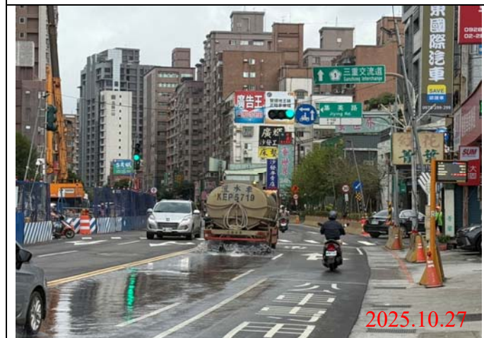
巡查日期地點：114.10.27 / Y22車站 照片說明：牌面設置狀況
