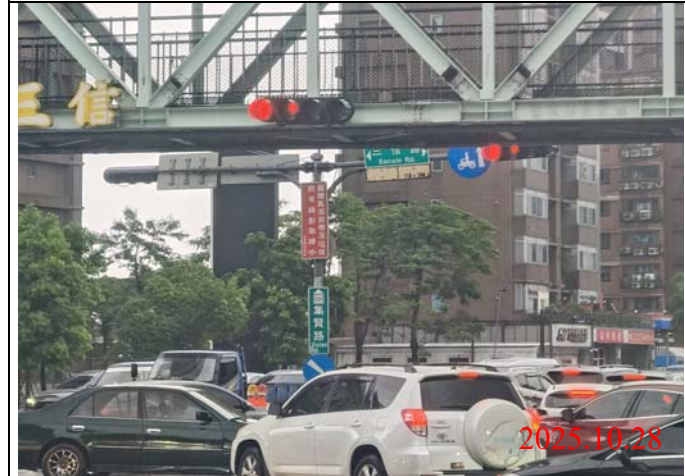
巡查日期地點：114.10.28 / Y23車站 照片說明：牌面設置狀況
