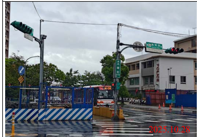
巡查日期地點：114.10.28 / Y22車站 照片說明：牌面設置狀況
