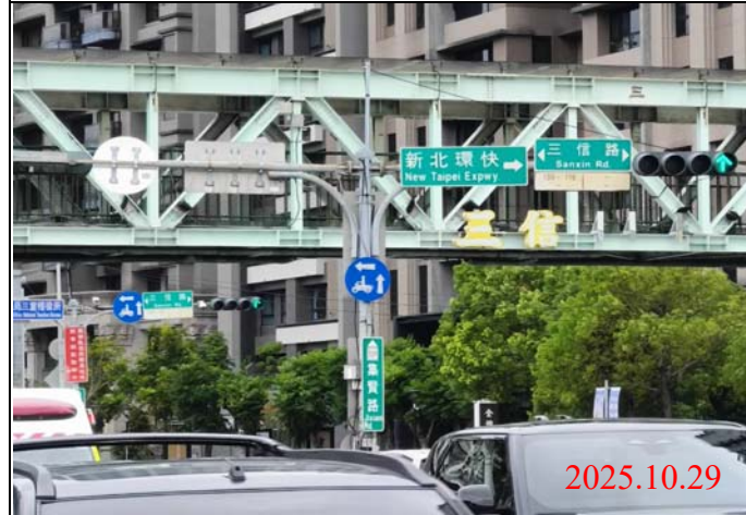
巡查日期地點：114.10.29 / Y23車站 照片說明：牌面設置狀況
