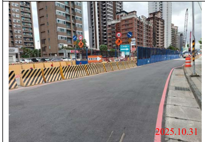
巡查日期地點：114.10.31 / Y23車站 照片說明：牌面設置狀況
