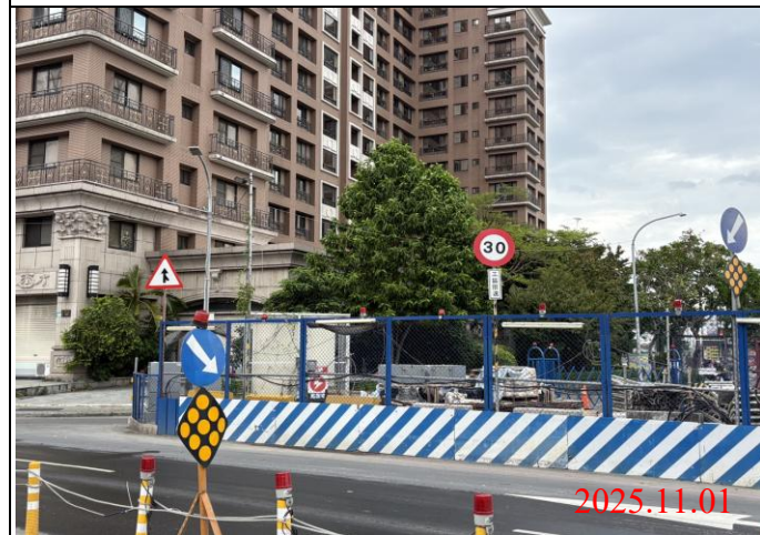
巡查日期地點：114.11.01/ Y22車站 照片說明：牌面設置狀況
