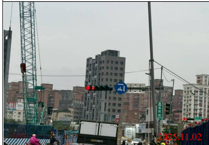
巡查日期地點：114.11.02/ Y22車站 照片說明：牌面設置狀況
