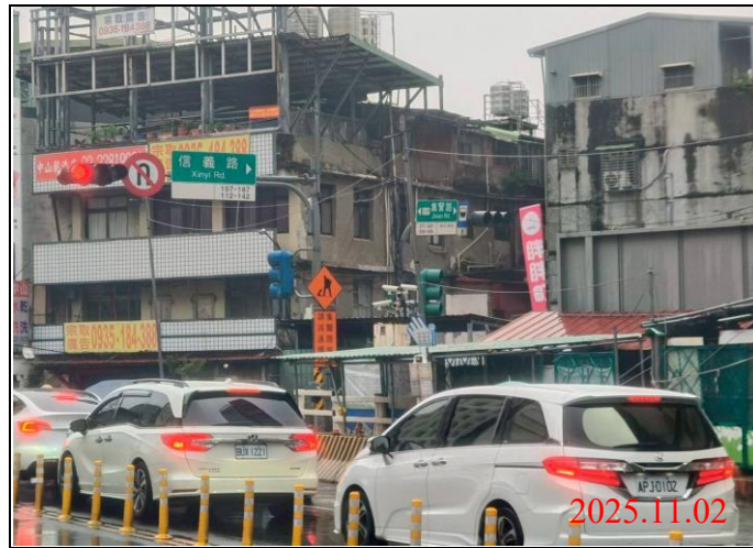
巡查日期地點：114.11.02/ Y21車站 照片說明：牌面設置狀況
