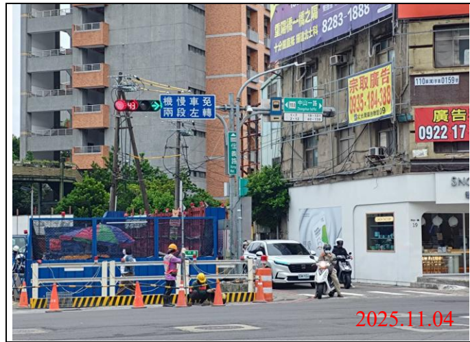
巡查日期地點：114.11.04/ Y21車站 照片說明：牌面設置狀況
