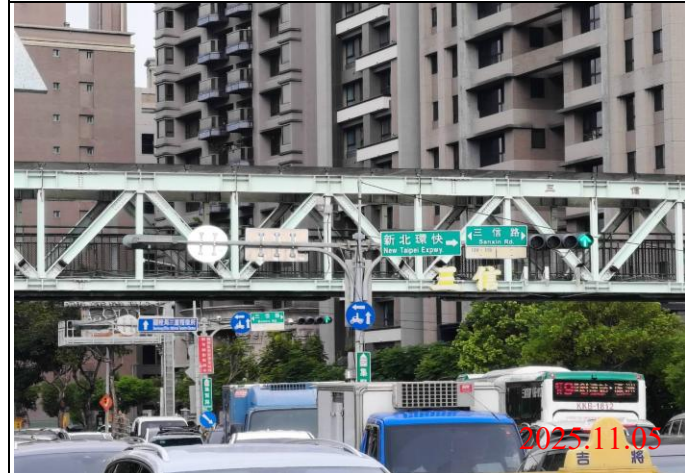
巡查日期地點：114.11.05/ Y23車站 照片說明：牌面設置狀況
