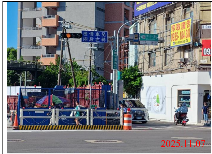
巡查日期地點：114.11.07 / Y21車站 照片說明：牌面設置狀況
