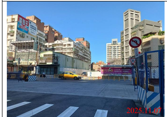
巡查日期地點：114.11.07 / Y22車站 照片說明：牌面設置狀況
