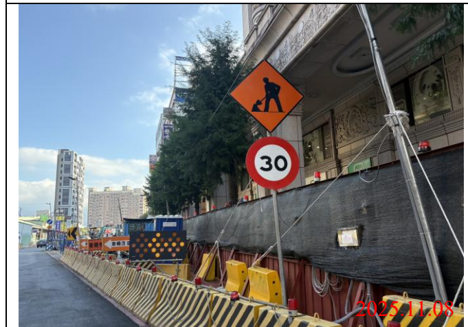
巡查日期地點：114.11.08 / Y22車站 照片說明：牌面設置狀況
