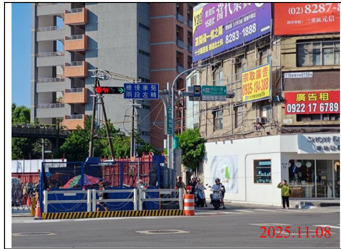
巡查日期地點：114.11.08 / Y21車站 照片說明：牌面設置狀況
