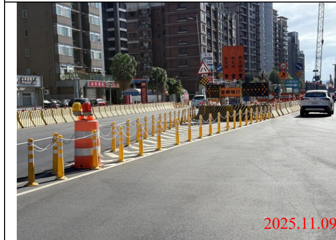
巡查日期地點：114.11.09 / Y23車站 照片說明：牌面設置狀況
