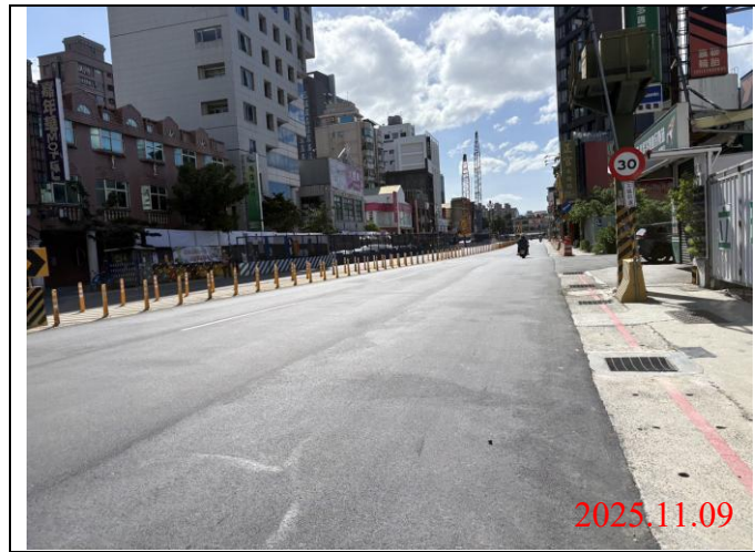
巡查日期地點：114.11.09 / Y21車站 照片說明：牌面設置狀況
