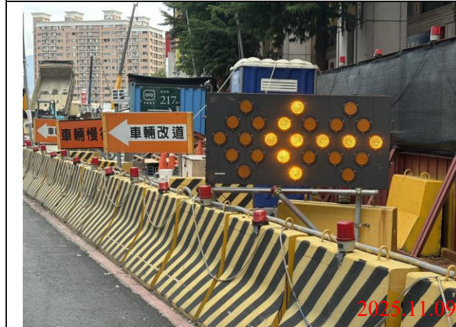
巡查日期地點：114.11.09 / Y22車站 照片說明：牌面設置狀況
