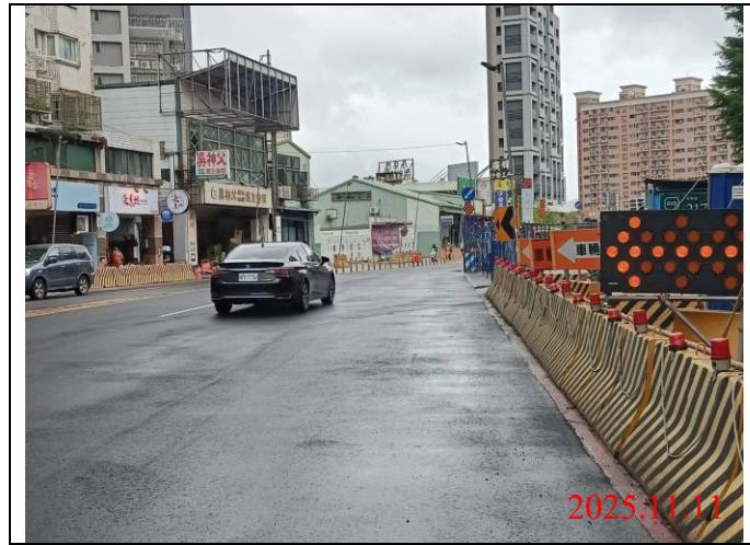
巡查日期地點：114.11.11 / Y22車站 照片說明：路面狀況
