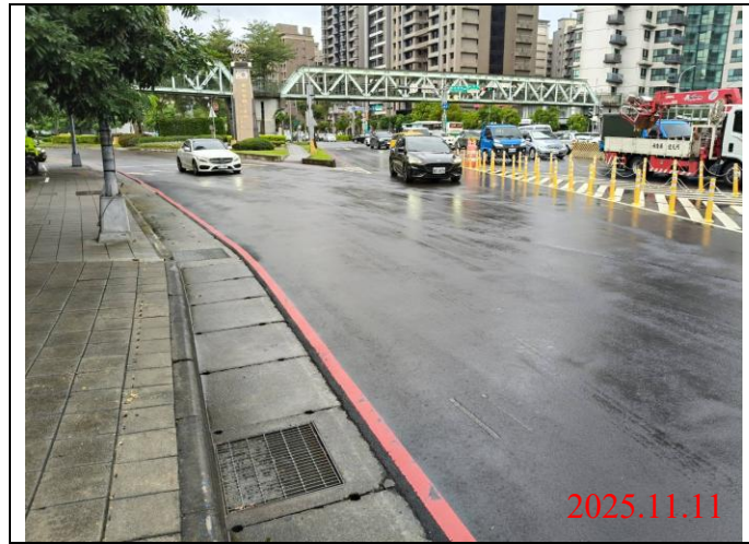
巡查日期地點：114.11.11 / Y23車站 照片說明：路面狀況
