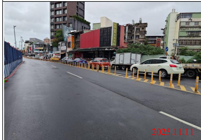
巡查日期地點：114.11.11 / Y23車站 照片說明：路面狀況
