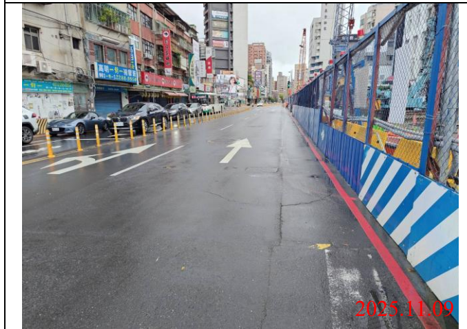
巡查日期地點：114.11.09 / Y21車站 照片說明：路面狀況
