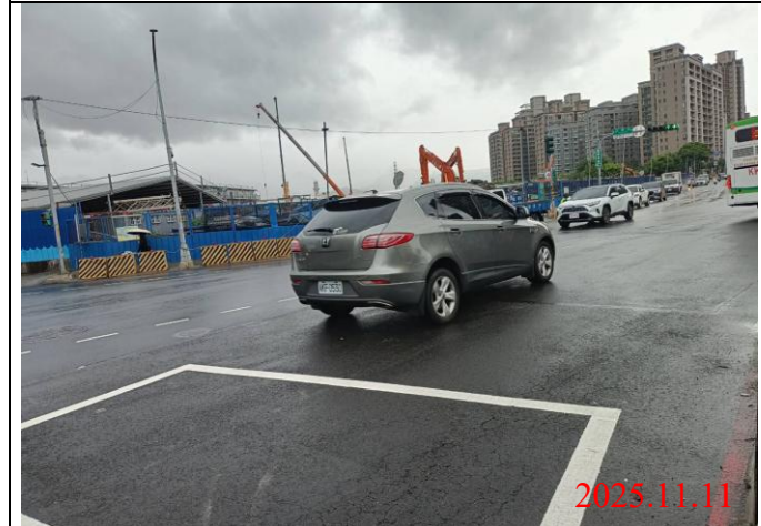
巡查日期地點：114.11.11 / Y22車站 照片說明：路面狀況
