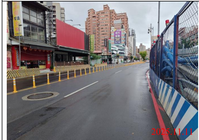
巡查日期地點：114.11.11 / Y21車站 照片說明：路面狀況
