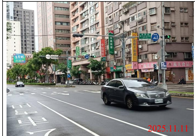
巡查日期地點：114.11.11 / Y22車站 照片說明：牌面設置狀況
