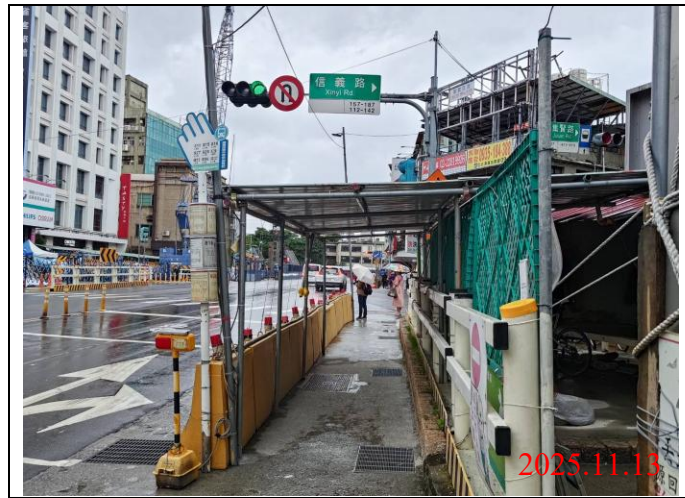
巡查日期地點：114.11.13 / Y21車站 照片說明：牌面設置狀況
