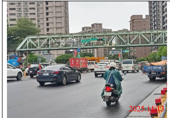
巡查日期地點：114.11.13 / Y23車站 照片說明：牌面設置狀況
