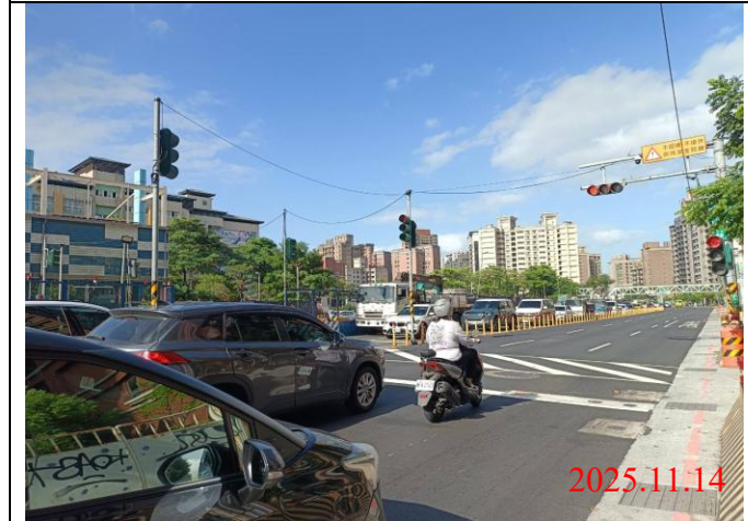
巡查日期地點：114.11.14 / Y23車站 照片說明：牌面設置狀況
