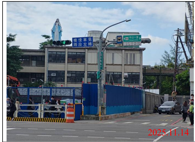
巡查日期地點：114.11.14 / Y21車站 照片說明：牌面設置狀況
