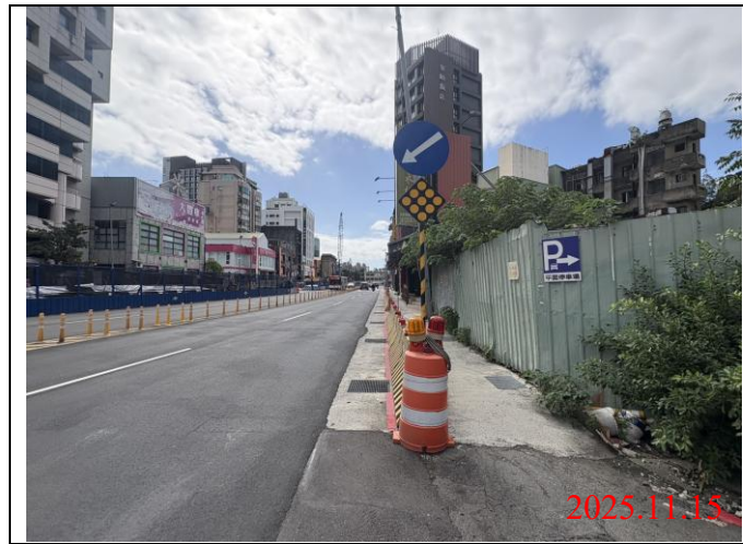
巡查日期地點：114.11.15 / Y21車站 照片說明：牌面設置狀況
