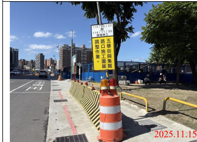
巡查日期地點：114.11.15 / Y22車站 照片說明：牌面設置狀況
