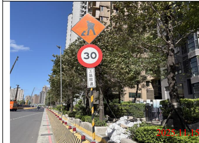
巡查日期地點：114.11.15 / Y23車站 照片說明：牌面設置狀況
