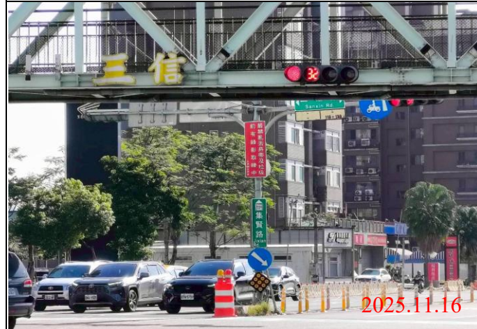
巡查日期地點：114.11.16/ Y23車站 照片說明：牌面設置狀況
