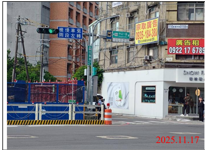
巡查日期地點：114.11.17 / Y21車站 照片說明：牌面設置狀況
