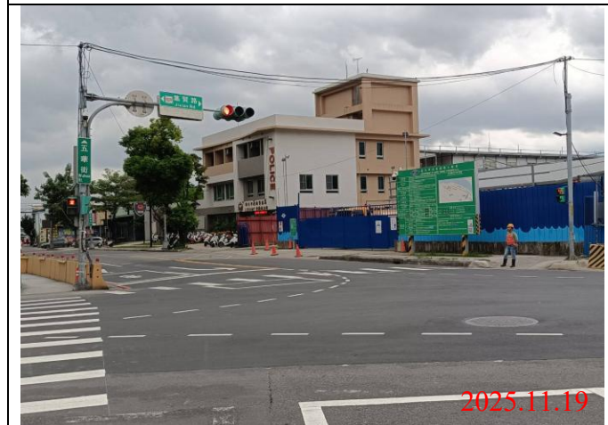
巡查日期地點：114.11.19 / Y22車站 照片說明：牌面設置狀況
