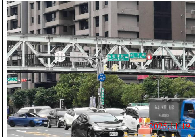
巡查日期地點：114.11.19 / Y23車站 照片說明：牌面設置狀況
