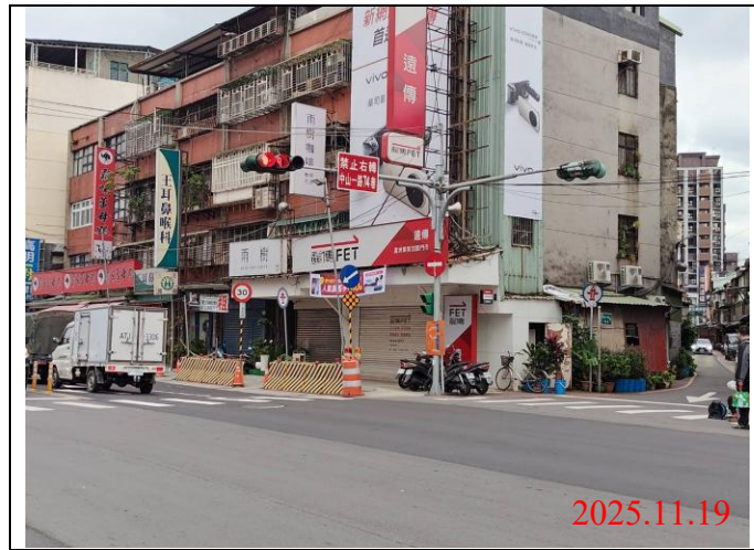
巡查日期地點：114.11.19 / Y21車站 照片說明：牌面設置狀況
