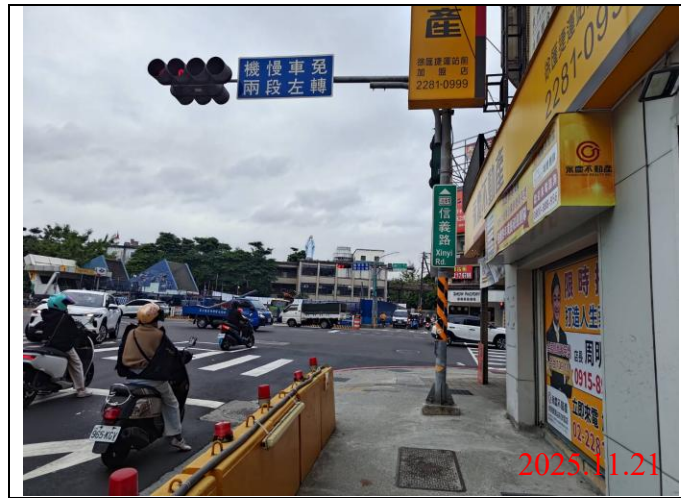
巡查日期地點：114.11.21 / Y21車站 照片說明：牌面設置狀況
