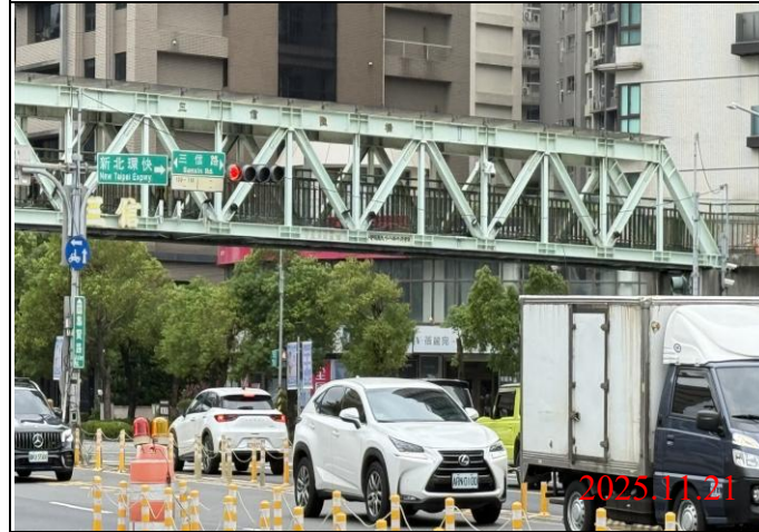
巡查日期地點：114.11.21 / Y23車站 照片說明：牌面設置狀況
