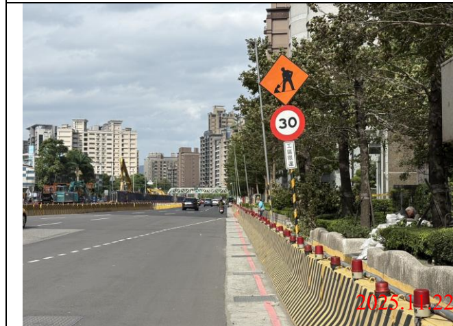
巡查日期地點：114.11.22 / Y23車站 照片說明：牌面設置狀況
