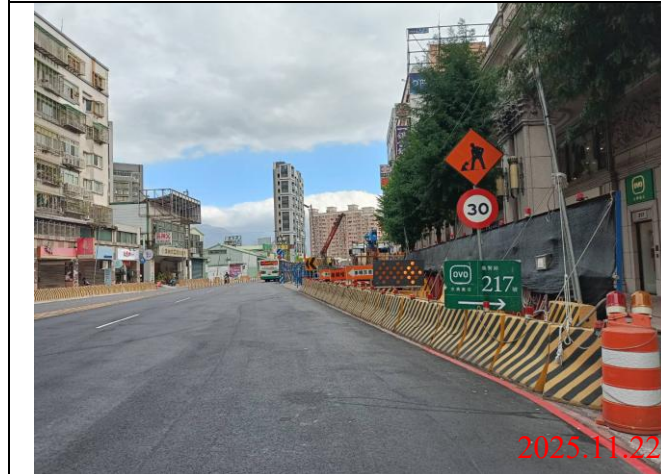
巡查日期地點：114.11.22 / Y22車站 照片說明：牌面設置狀況
