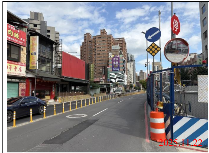
巡查日期地點：114.11.22/ Y21車站 照片說明：牌面設置狀況
