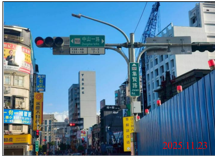
巡查日期地點：114.11.23/ Y21車站 照片說明：牌面設置狀況
