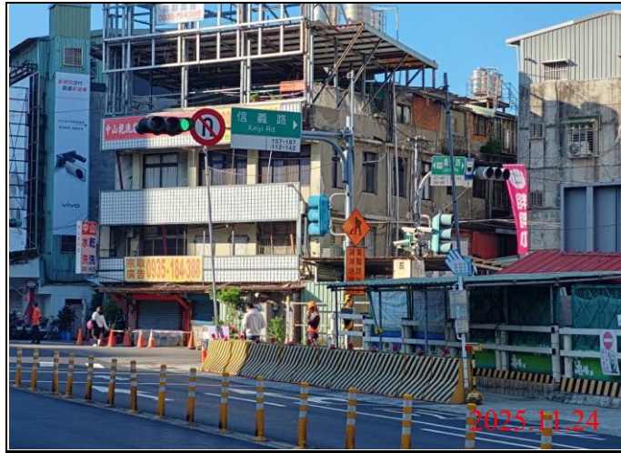
巡查日期地點：114.11.24/ Y21車站 照片說明：牌面設置狀況
