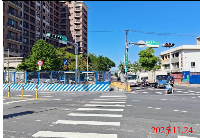
巡查日期地點：114.11.24/ Y22車站 照片說明：牌面設置狀況
