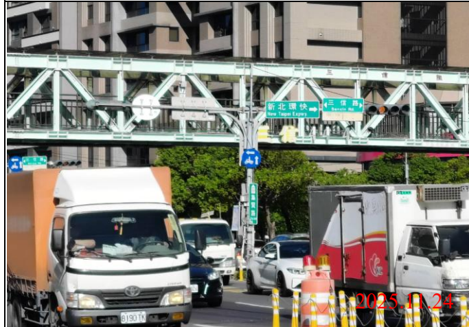
巡查日期地點：114.11.24/ Y23車站 照片說明：牌面設置狀況
