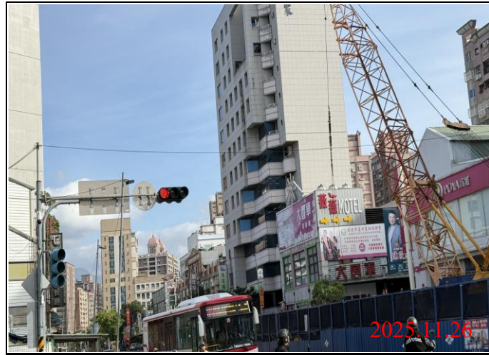
巡查日期地點：114.11.26 / Y21車站 照片說明：牌面設置狀況
