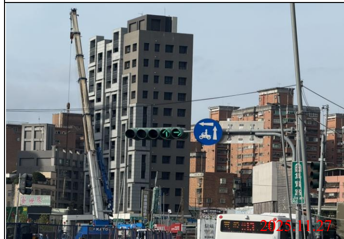
巡查日期地點：114.11.27 / Y22車站 照片說明：牌面設置狀況
