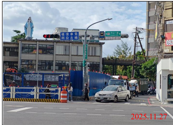
巡查日期地點：114.11.27 / Y21車站 照片說明：牌面設置狀況
