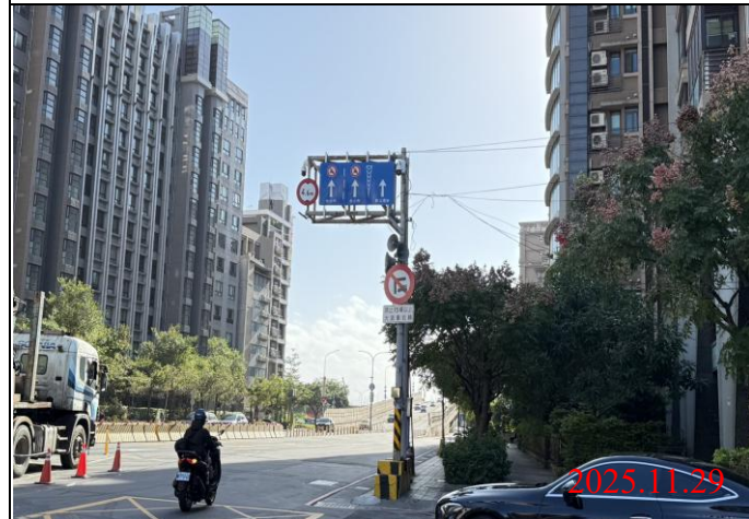
巡查日期地點：114.11.29 / Y23車站 照片說明：牌面設置狀況
