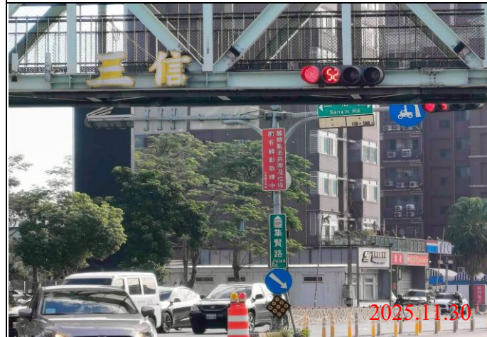
巡查日期地點：114.11.30/ Y23車站 照片說明：牌面設置狀況
