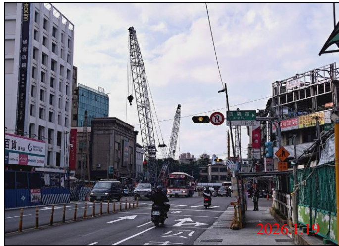
巡查日期地點：115.1.19/ Y21車站 照片說明：牌面設置狀況
