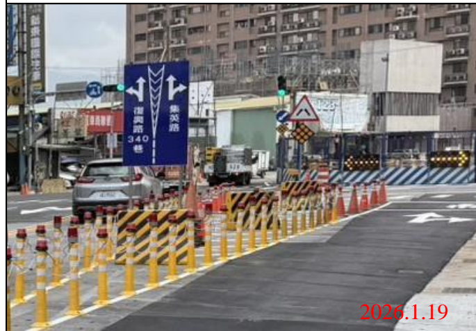
巡查日期地點：115.1.19/ Y22車站 照片說明：牌面設置狀況
