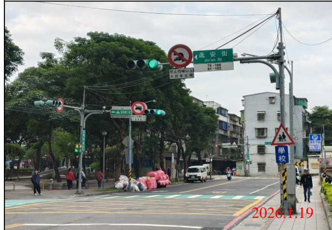
巡查日期地點：115.1.19/ Y23車站 照片說明：牌面設置狀況
