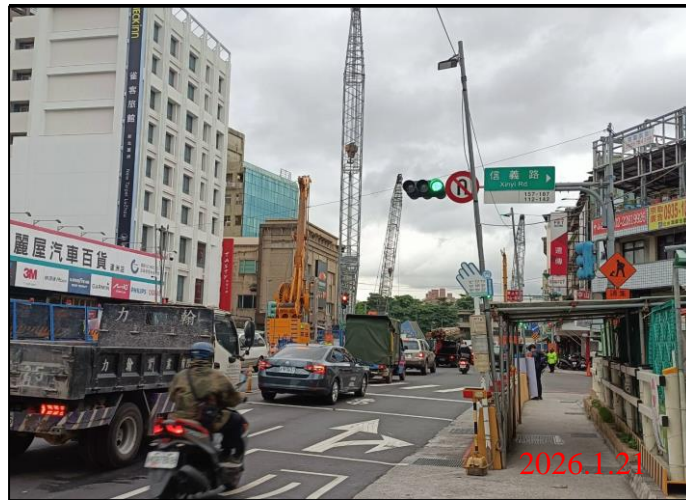
巡查日期地點：115.1.21/ Y21車站 照片說明：牌面設置狀況
