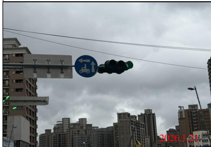
巡查日期地點：115.1.21/ Y22車站 照片說明：牌面設置狀況
