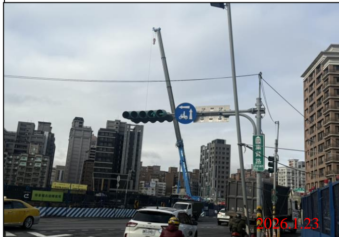
巡查日期地點：115.1.23/ Y22車站 照片說明：牌面設置狀況
