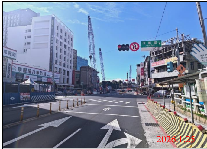
巡查日期地點：115.1.25/ Y21車站 照片說明：牌面設置狀況
