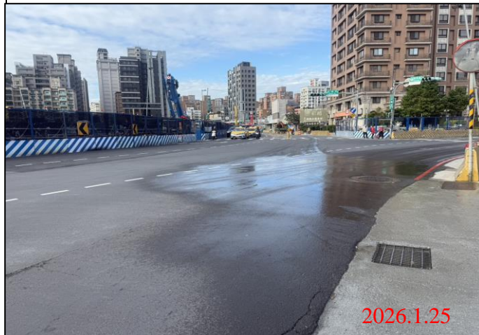
巡查日期地點：115.1.25/ Y22車站 照片說明：牌面設置狀況
