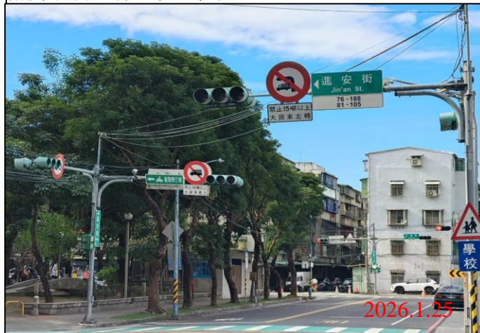
巡查日期地點：115.1.25/ Y23車站 照片說明：牌面設置狀況
