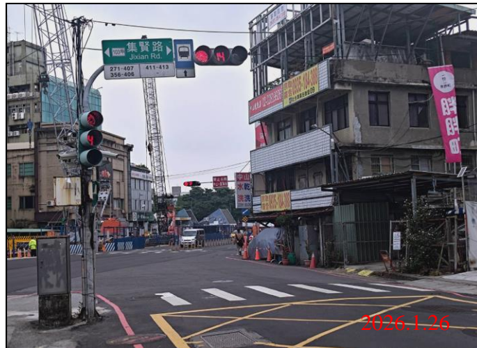
巡查日期地點：115.1.26/ Y21車站 照片說明：牌面設置狀況
