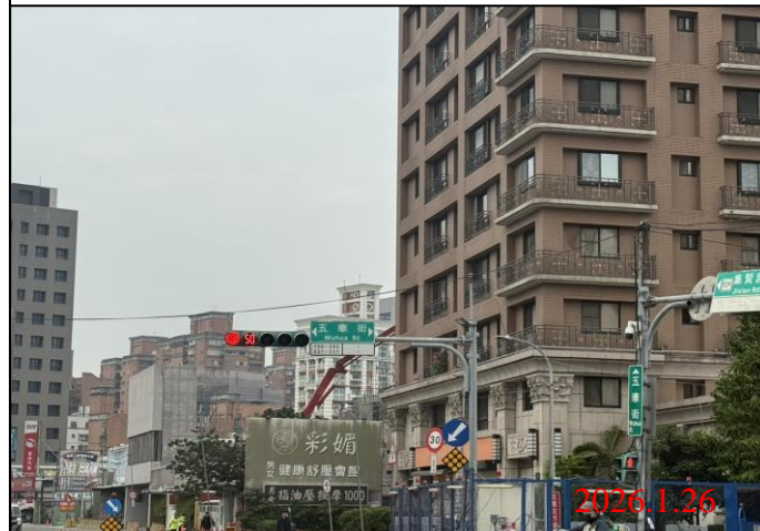
巡查日期地點：115.1.26/ Y22車站 照片說明：牌面設置狀況
