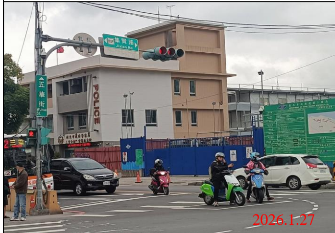
巡查日期地點：115.1.27/ Y22車站 照片說明：牌面設置狀況
