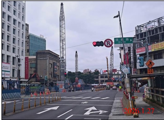
巡查日期地點：115.1.27/ Y21車站 照片說明：牌面設置狀況
