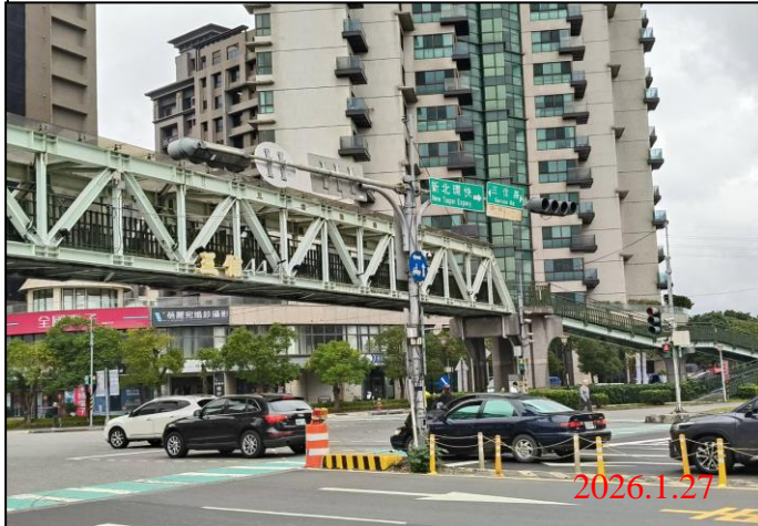
巡查日期地點：115.1.27/ Y23車站 照片說明：牌面設置狀況
