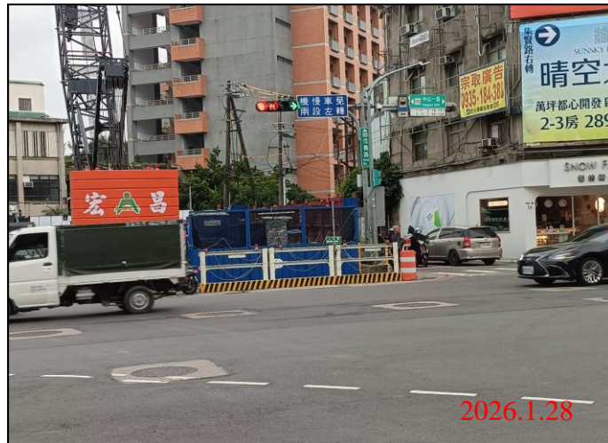
巡查日期地點：115.1.28/ Y21車站 照片說明：牌面設置狀況
