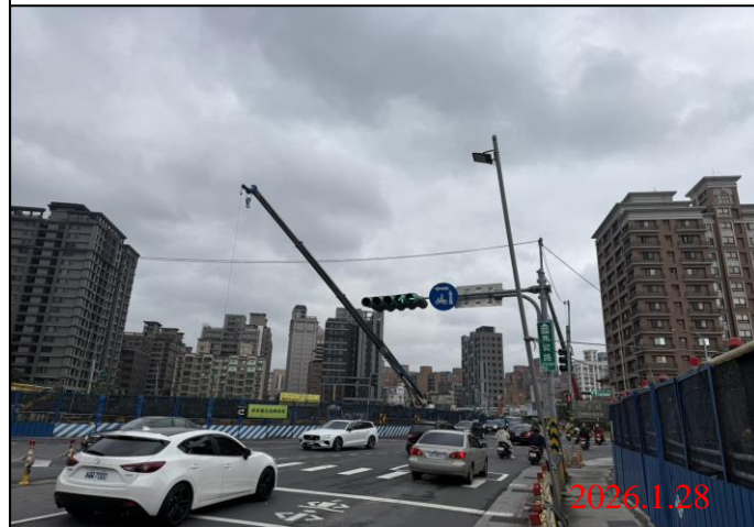
巡查日期地點：115.1.28/ Y22車站 照片說明：牌面設置狀況
