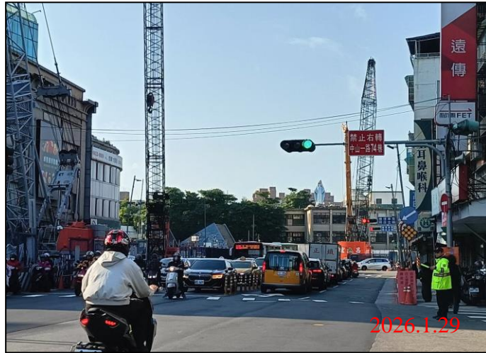
巡查日期地點：115.1.29/ Y21車站 照片說明：牌面設置狀況
