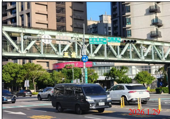
巡查日期地點：115.1.29/ Y23車站 照片說明：牌面設置狀況
