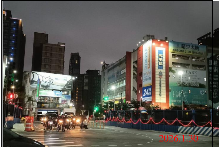
巡查日期地點：115.1.30/ Y22車站 照片說明：夜間路面、路燈及警示燈狀況
