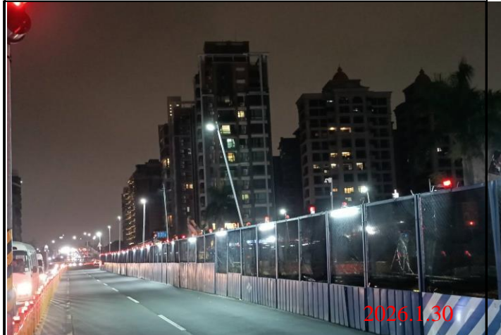
巡查日期地點：115.1.30/ Y23車站 照片說明：夜間路面、路燈及警示燈狀況
